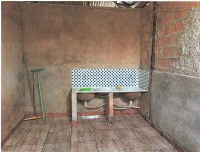
Foto 1.16 e 1.17 – Vista da Área de Serviço
